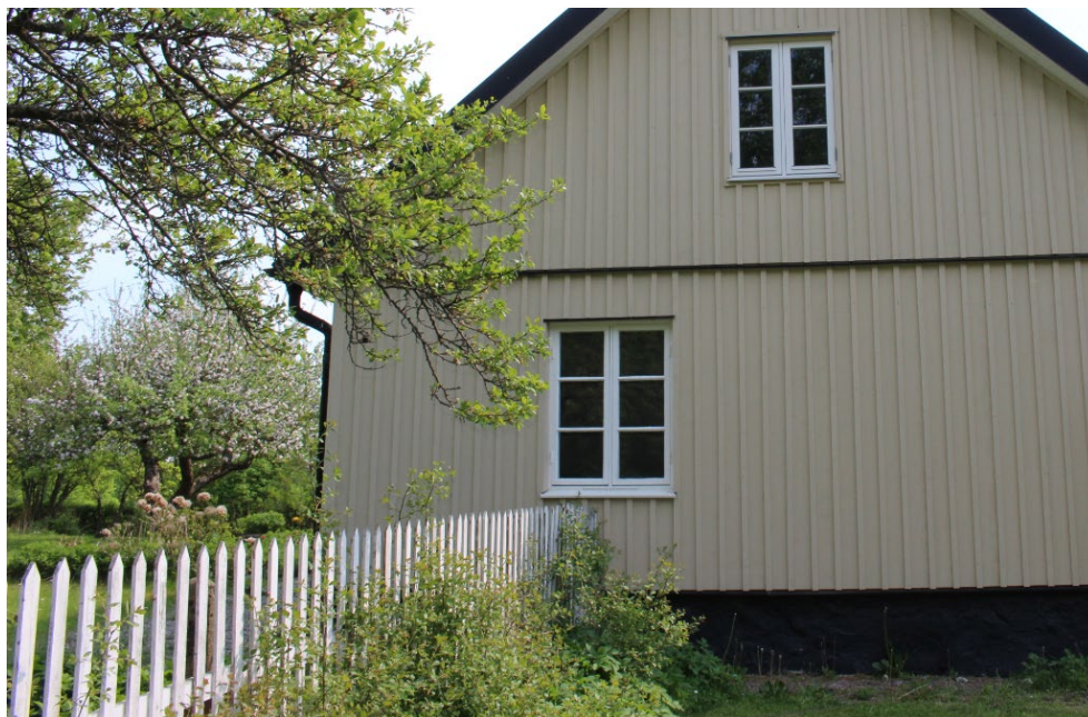
Befintligt staket inom Gatehusen 5.
