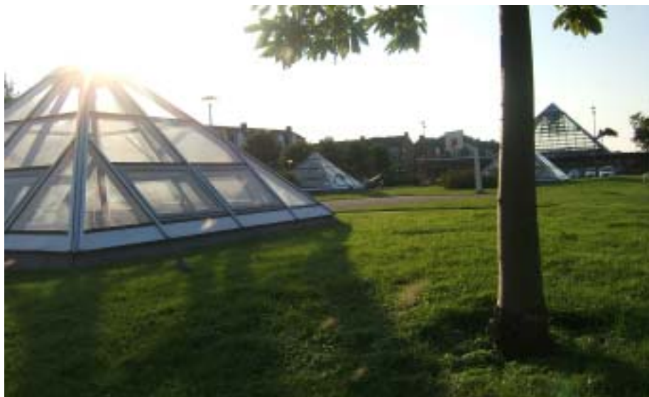
Stationsområdet i Rijswijk. Glaspyramiderna släpper in ljus till det överdäckade spårområdet och är samtidigt ett dekorativt inslag efter mörkrets inbrott. Foto: Milo Vermeulen
